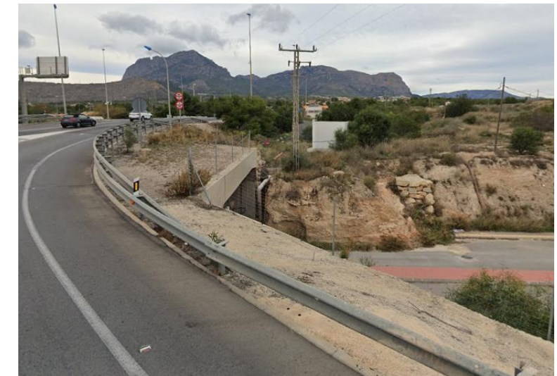
Vista del saliente a desmontar.
