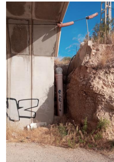
Tubería junto estribo Noreste
